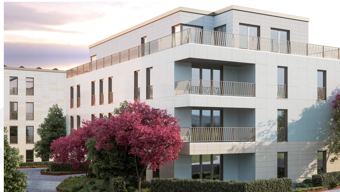
Façade ventilée, balcons et attique en retrait ; structure bois TS3 derrière le bardage
