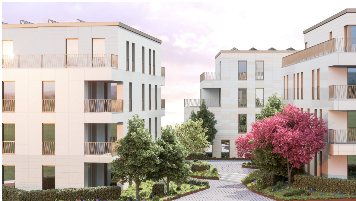
Les trois bâtiments autour du cheminement central ; en toiture, les panneaux photovoltaïques
